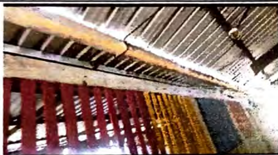
Foto 1: Se necesita un canal de 25m de largo X 50cm de ancho.
